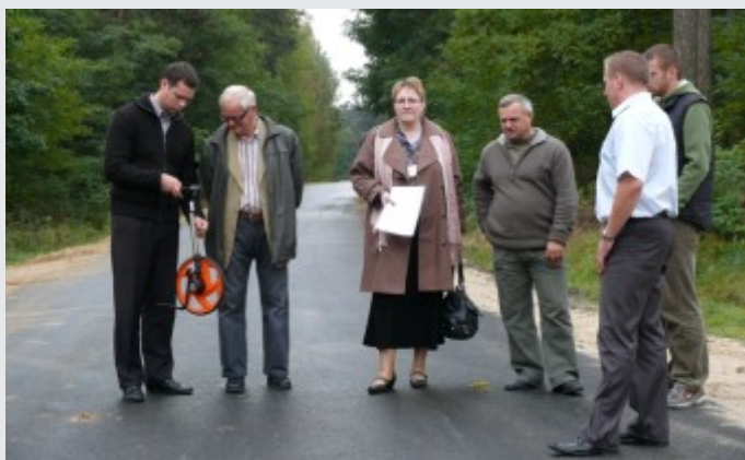
Odbiór drogi przy udziale przedstawicieli Urzędu Marszałkowskiego foto: bw
