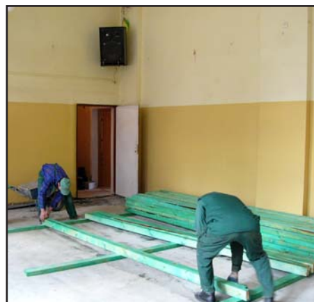
Remonty w budynkach OK w gminie fot. pp
