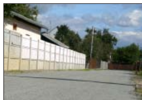
Nowa droga w Rudzie Łańcuckiej
